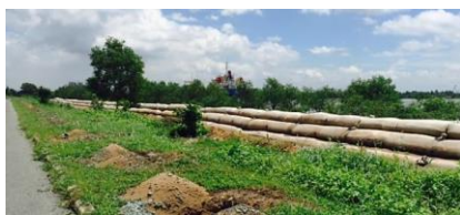
Hình 4. Đê mềm bằng ống ĐKT trong ứng dụng chống xói lở, bảo vệ bờ.
