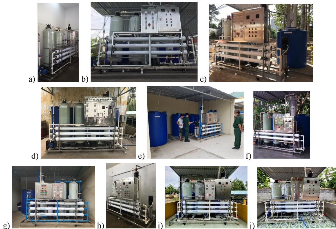
Hình 6. Các hệ thống xử lý nước nhiễm mặn thành nước ngọt đã lắp đặt tại các đơn vị gồm: a) Ban CHQS Huyện Long Mỹ/Hậu Giang; b) Bộ CHQS tỉnh Sóc Trăng; c) Ban CHQS Huyện Trà Cú/Trà Vinh; d) Ban CHQS Huyện Giồng Trôm/Bến Tre; e) Trung đoàn 895 thuộc Bộ CHQS Bến Tre; f) Ban CHQS Huyện An Minh/Kiên Giang; g) Trung đoàn 893 thuộc Bộ CHQS Kiên Giang; h) Ban CHQS TP. Bạc Liêu/tỉnh Bạc Liêu; i) Ban CHQS huyện Châu Thành tỉnh Sóc Trăng; j) Ban CHQS Huyện Tân Hưng/Long An.
