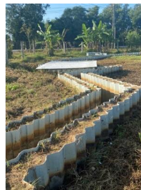
Hình 5. Ứng dụng cừ bản nhựa làm hào vận động tại Bộ CHQS tỉnh Hậu Giang.
