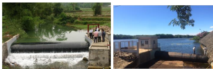
Hình 3. Đập cao su tăng cường khả năng tích nước an toàn.
